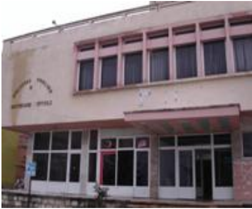
L'aspetto esterno della biblioteca pubblica di Pogradec
